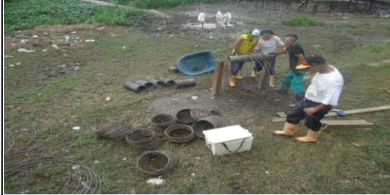
Foto 2: Refuerzo para pilotes
