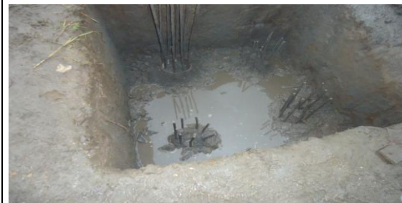
Foto 8: Fundida de zapatas
