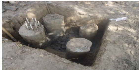
Foto 7: Instalacion de refuerzo para zapatas y columnas
