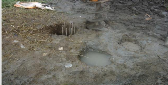
Foto 6: Excavacion para zapatas
