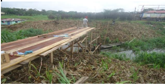
Plataformas para perforar en el puente 1
